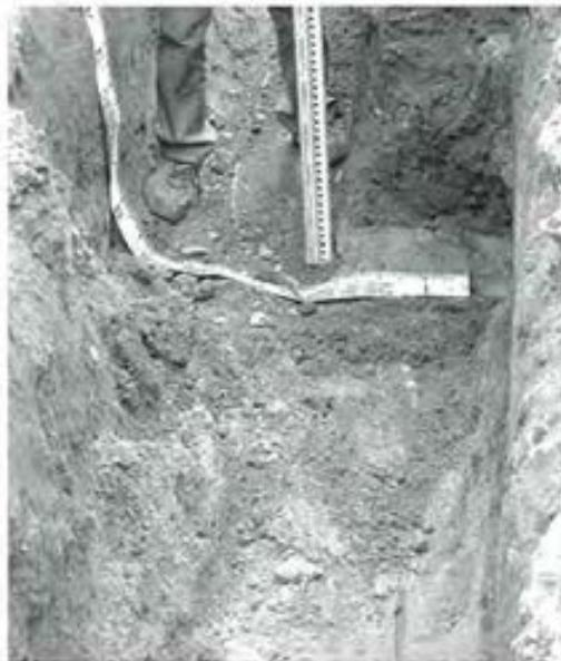
図-12 PE二層管に布設替え後
