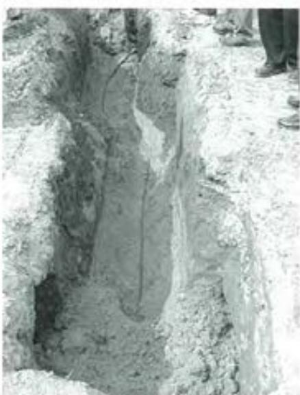
図-9 布設替え後のPE二層管
