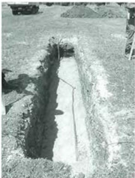
図-8 鉛給水管の埋設時
