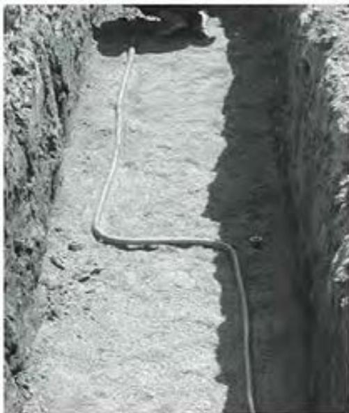
図-11 鉛給水管の埋設時
