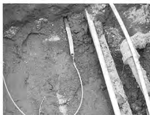
図-13 ヒーター加熱中の鉛給水管
