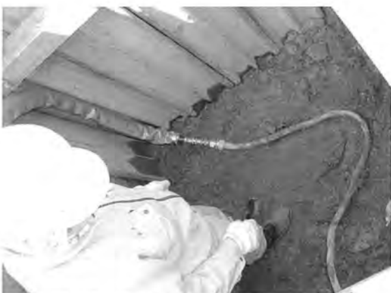
図-7 温水による加圧膨張ライニング
