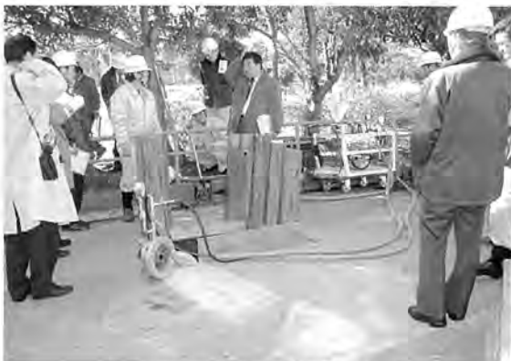
図-3 反転後の温水の循環
