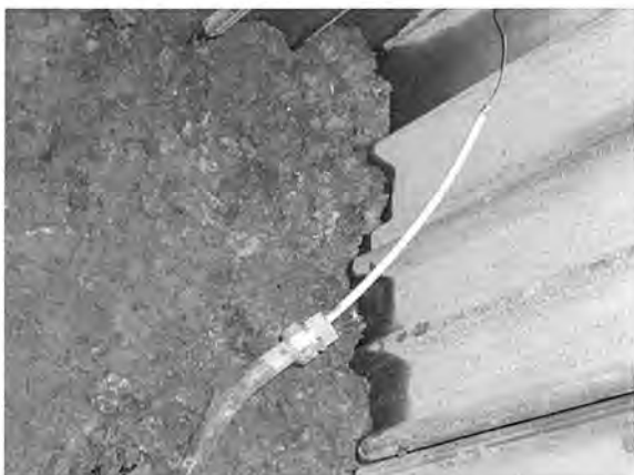
図-6 PET管挿入完了
