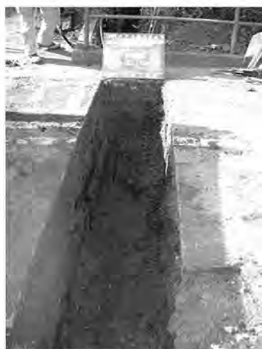
図-12 布設替後のPE管の位置確認
