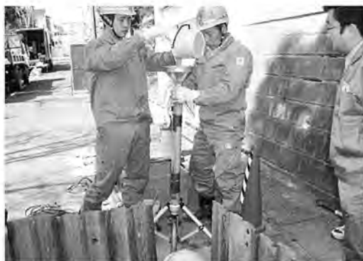
図-10 鉛給水管への樹脂の充填
