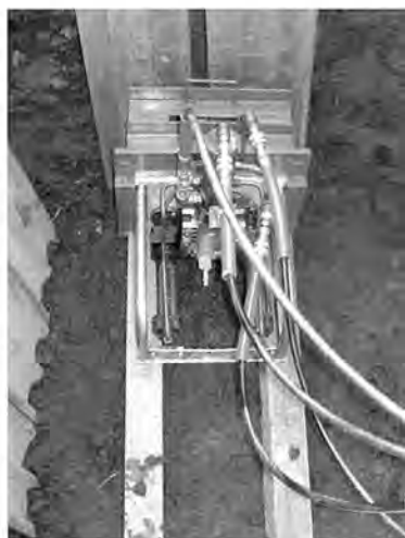
図-11 一体化した鉛給水管の引き抜きと布設替え装置
