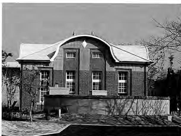
八景水谷取水井と水道記念館 取水井…創設時から現在も使用中 記念館…旧八景水谷水源ポンプ場
