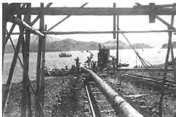
岳路から高島への海底送水管布設工事
