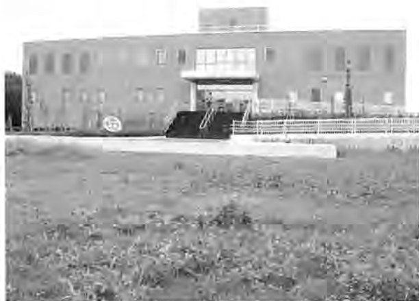
写真-1 砧浄水場膜ろ過棟
