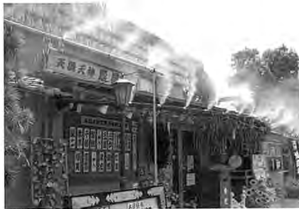
写真-2 天満天神繁昌亭でのミスト散布状況
