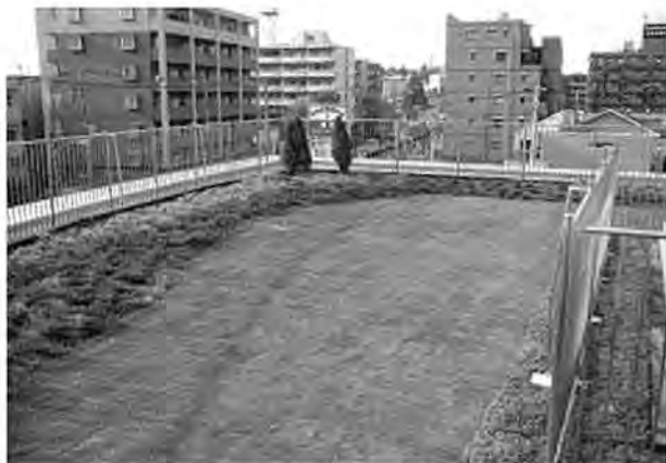
写真-1 屋根の緑化状況
