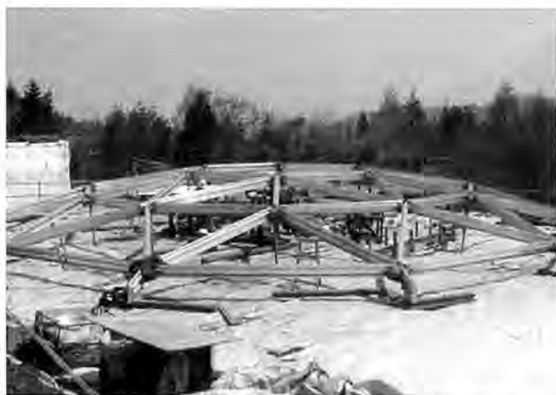
写真-2 アルミニウム合金製屋根の施工例
