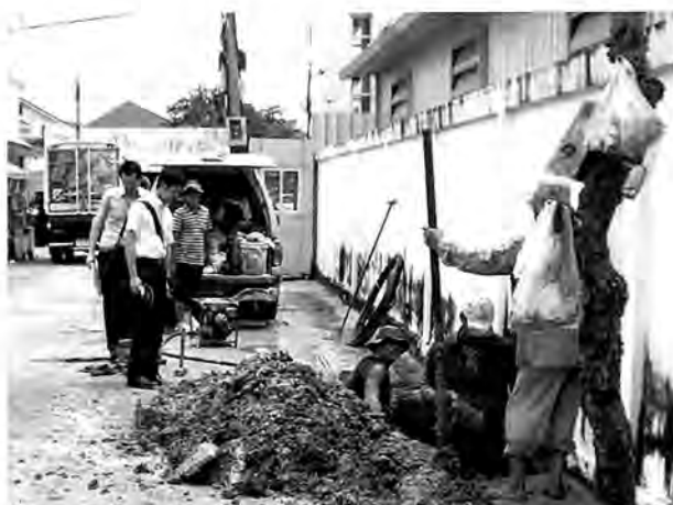
写真-1 (視察風景)タイの漏水修理工事現場視察
