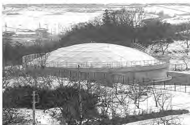
写真-1 アルミニウム合金製屋根工法の一例
