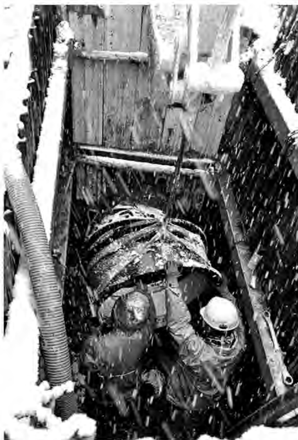
写真-2 雪の降る中での復旧作業(宮城県管工業協同組合提供)
