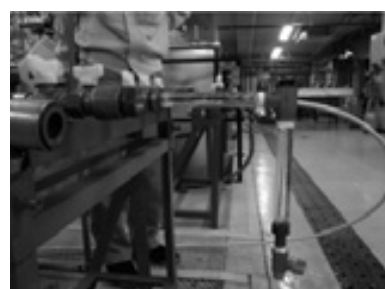
写真-4 一次側満水時逆圧逆流
