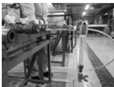
写真-3 一次側開放時の逆圧排水
