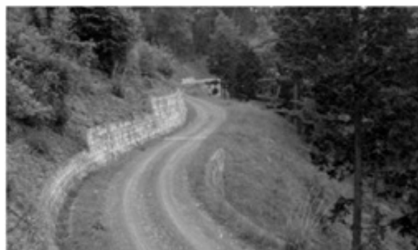
写真-5 開設した林道
