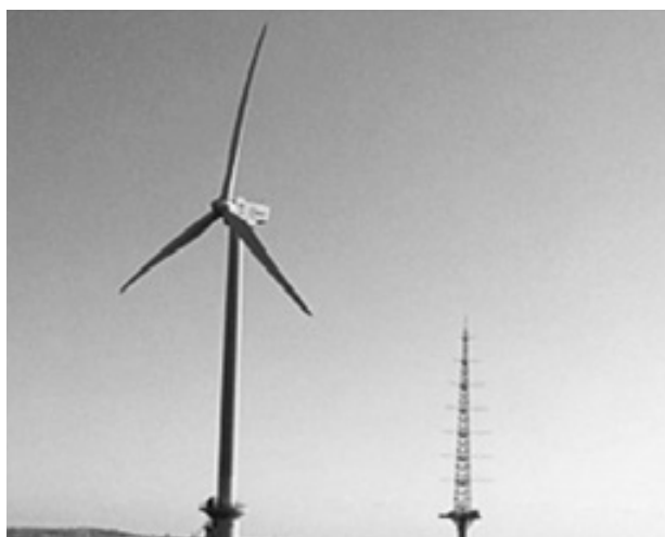
写真-1 銚子沖洋上風力発電
