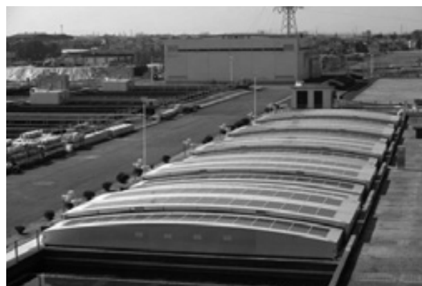
写真-4 ろ過池覆蓋上部の太陽光発電
