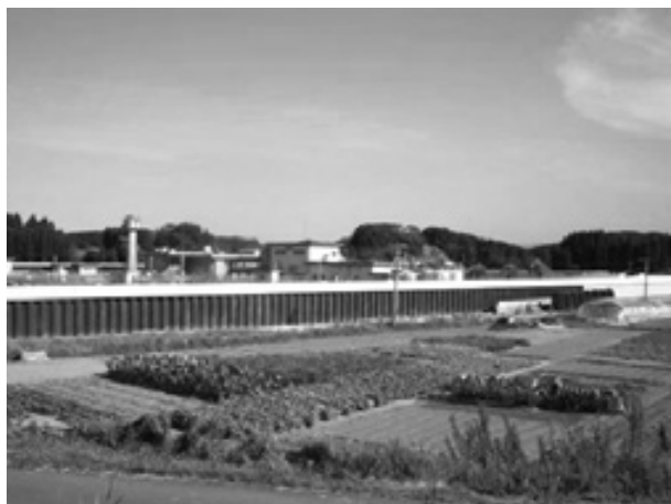
写真-4 完成した浸水防止機能保全施設
