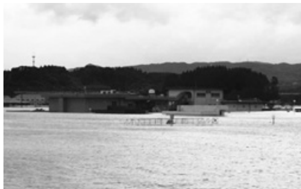
写真-1 水没した富吉浄水場 2005年9月6日
