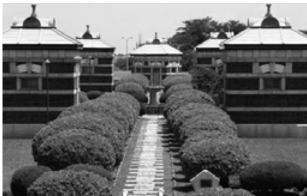
写真-3 現在のろ過池整水室上屋等(登録文化財)
