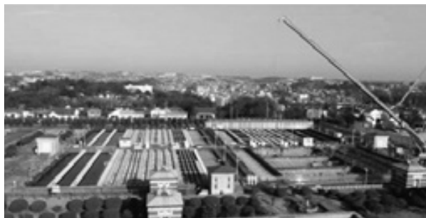
写真-5 沈でん池耐震補強工事 (平成23~26年度(予定))
