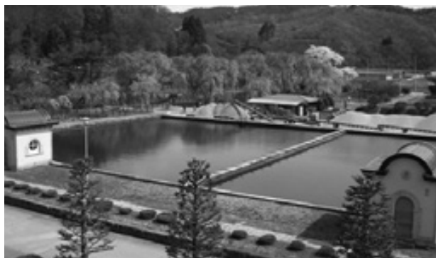
写真-2 米内浄水場緩速ろ過池
