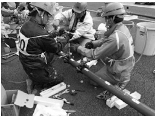
写真-9 分岐穿孔作業
