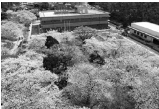
写真-1 桜が満開の越水浄水場
