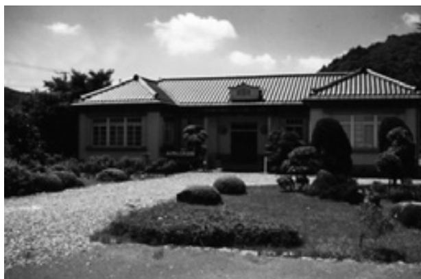
写真-4 国の文化財 水道記念館 (中央の屋根に突き出しているのがドーマー窓)
