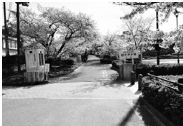
写真-2 越水浄水場入口
