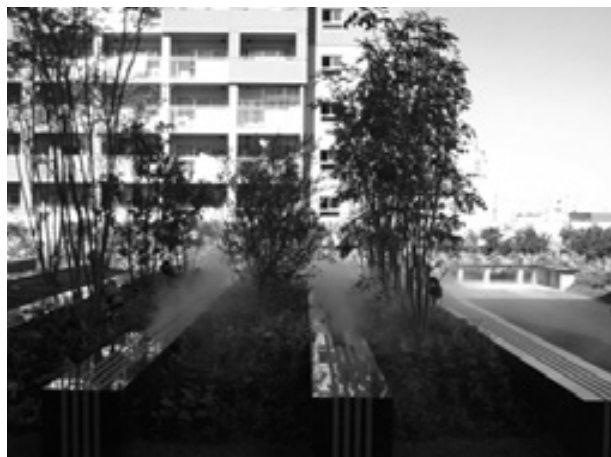
屋上緑化とミストの例／住友ゴム工業屋上(2009)
