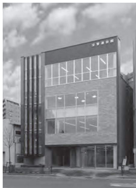
2月に竣工した新たな全管連会館
