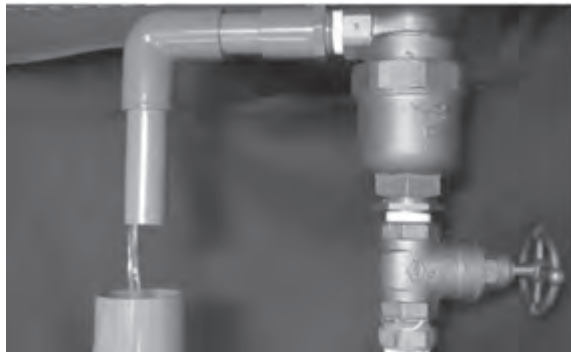
(a) 滞留状況の確認
