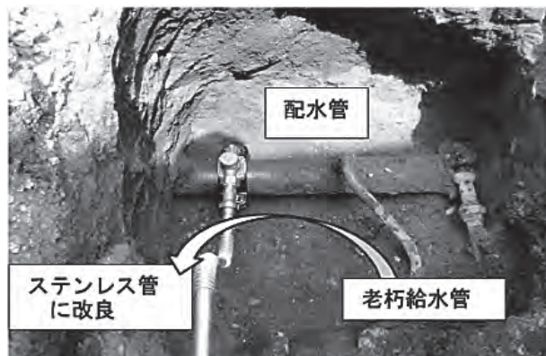
写真4 道路内老朽給水管 改良状況
