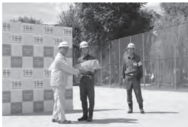
写真10 上下水道局から仮設給水栓 32 基を寄託
