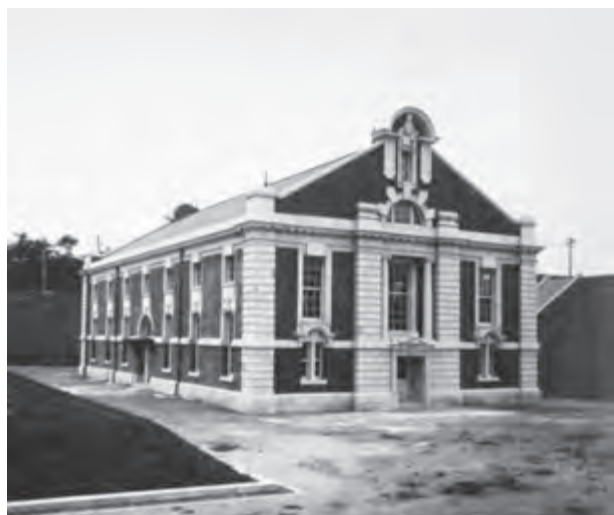
写真1 鍋屋上野浄水場(創設時の第一ポンプ所)
