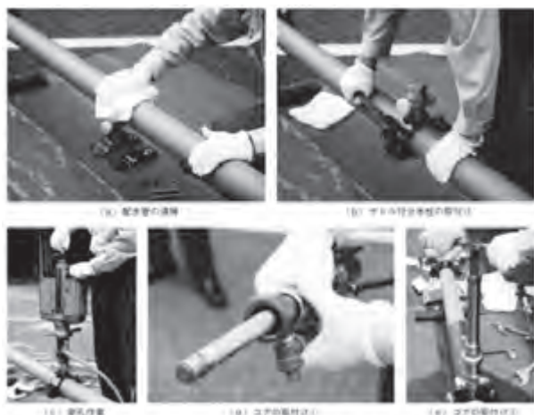
図 1 サドル付分水栓取付作業工程の写真例
