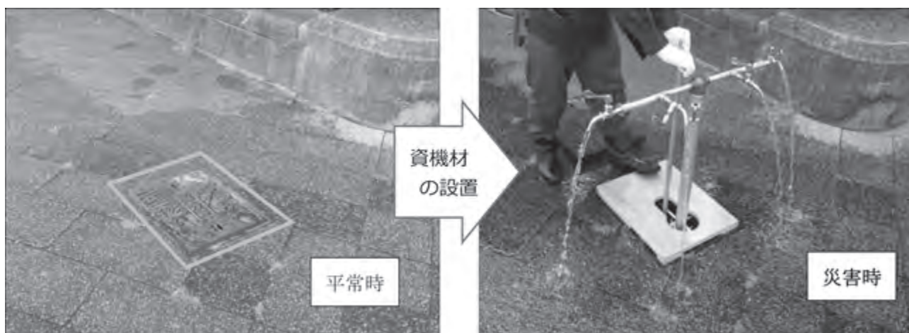
写真1 仮設給水栓の設置
