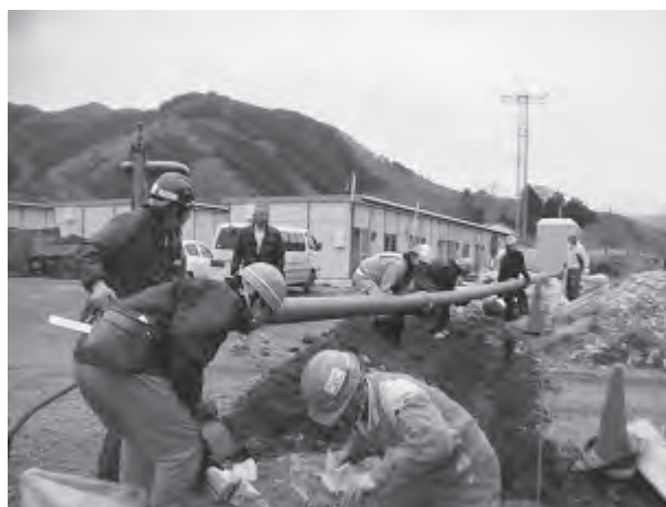
写真5 災害復旧現場で活躍するエスロハイパー
