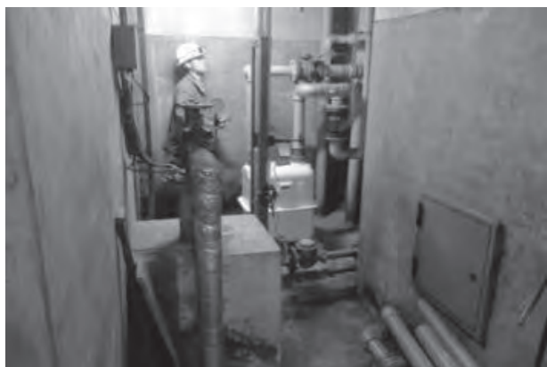
写真2 立入調査の様子
