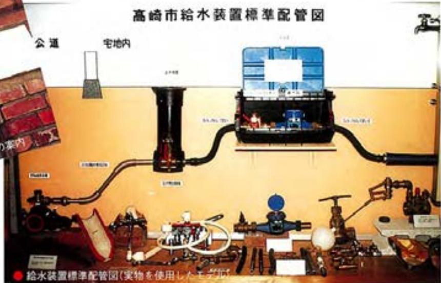
●給水装置標準配管図(実物を使用したモック)
