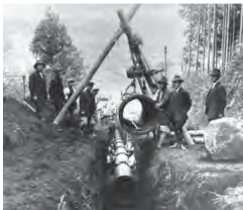
写真-1 立田山送水管布設工事（大正期）
