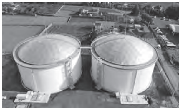
北部配水場（令和3年12月竣工）
