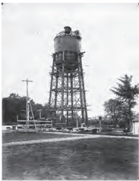
建設中の浦和浄水場（昭和12年竣工）
