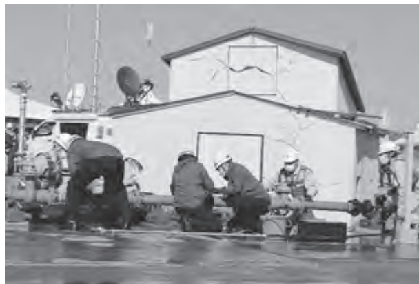
さいたま市総合防災訓練 -ライフライン応急復旧訓練-
