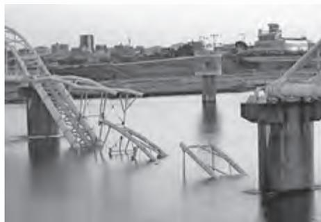
Photo. 2 六十谷水管橋の崩落状況
