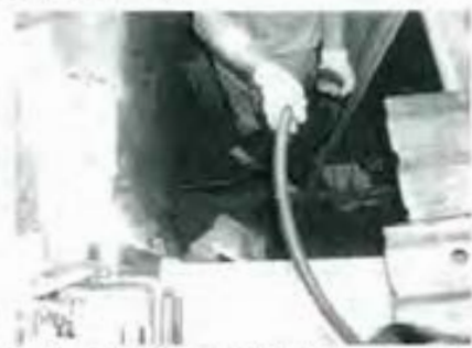
図-5 引き込み中のポリエチレン二層管
