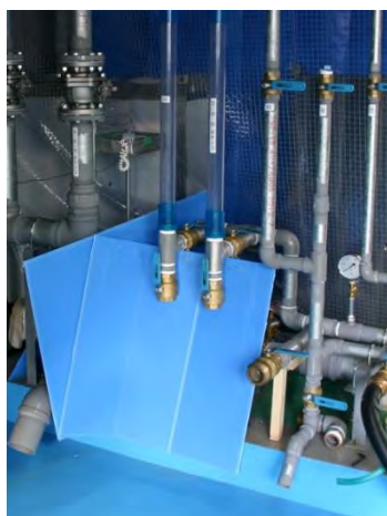
立管基部：50 同径（中央左透明管）
