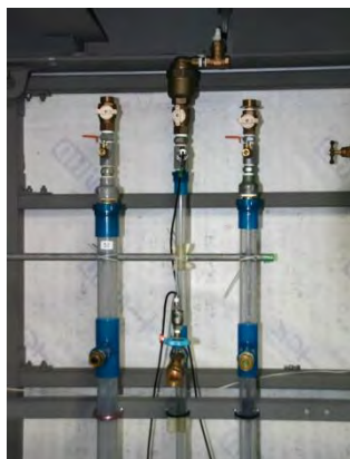
立管頂部：25 吸排気弁(840L/min 固定)
