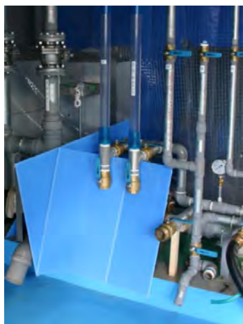
立管基部：50 同径（中央左透明管）
