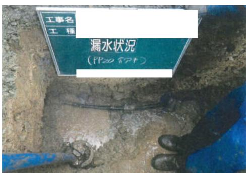
写真 1.3.3 破損部
