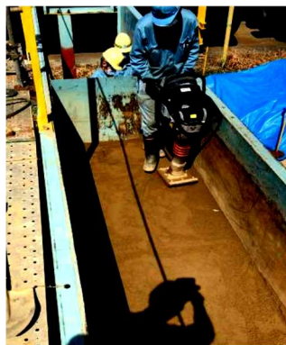
図 6-4 締め固め
